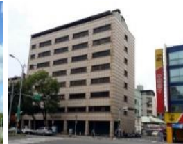
福全新整棟 客戶:救國團 面積:1,271坪(全棟)
