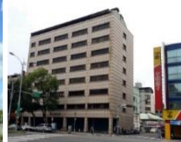
福全新整棟 客戶:救國團 面積:1,271坪(全棟)
