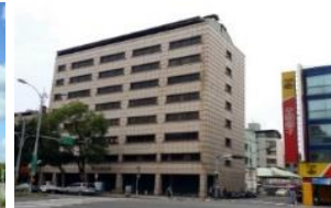
福全新整棟 客戶:救國團 面積:1,271坪(全棟)
