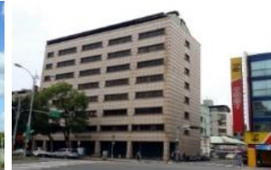
福全新整棟 客戶:救國團 面積:1,271坪(全棟)
