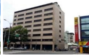
福全新整棟 客戶:救國團 面積:1,271坪(全棟)
