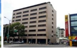
福全新整棟 客戶:救國團 面積:1,271坪(全棟)
