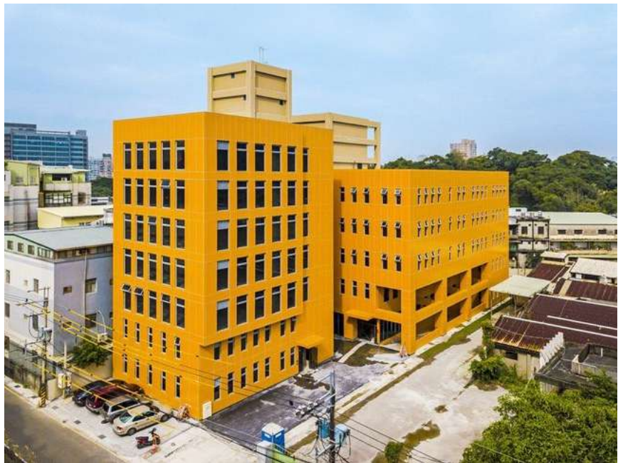
▲安信建經代建廠辦大樓 - 「盛元承天」案位於永寧捷運站附近，預計於今年上半年度落成
