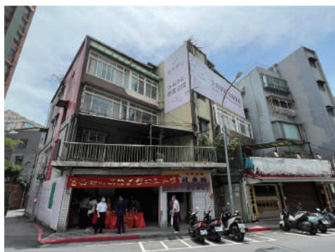
▲圖為景美「富品靜心」該案原址，現狀地上物已拆除。
